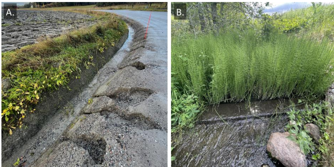
Kuva 6. A. Lampisträsketin laskuojaan laskevan sivu-uoman viereisen Mustfinnintien varrella olevia eroosiokohtia. B. Gräggböleträsketin laskuojassa oleva pohjapato kuvattuna 25.6.2025 valuma-aluekartoituksen yhteydessä.
