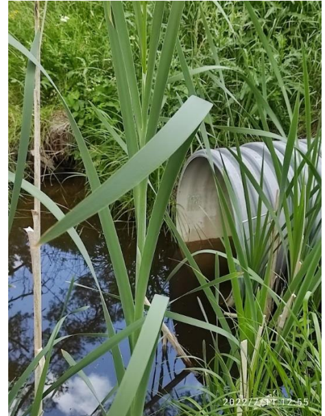
Kuva 18: Lähellä ojan suuta oleva tierumpu muodostaa osittaisen vaellusesteen meriveden ollessa matalalla.
