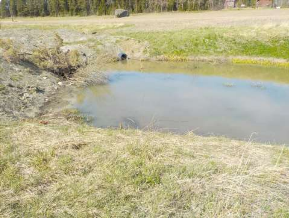
Kuva 3. Kosteikkorakentamista Ruopanojalla (Pasi Salmi).
