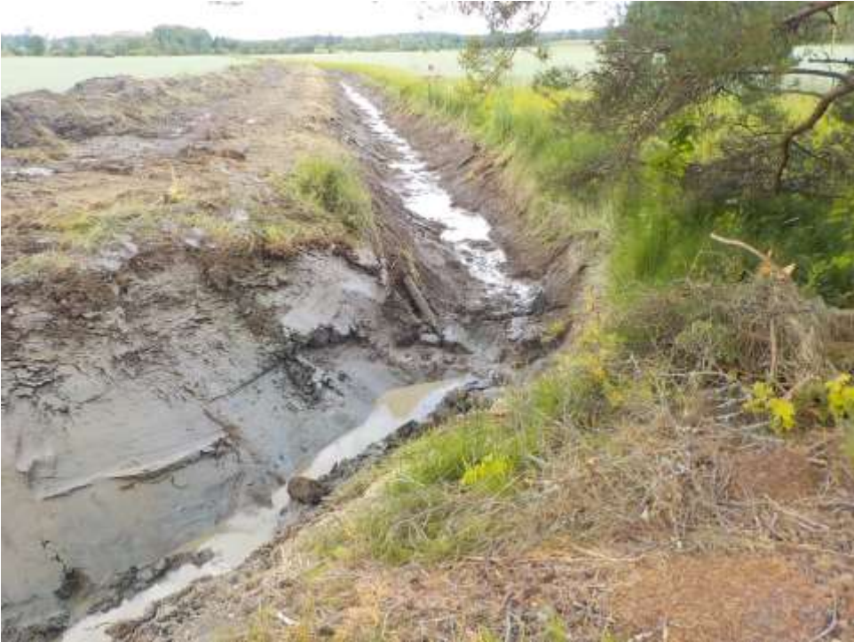
Kuva 2. Kunnostusojitusta Pukkilanojalla (Pasi Salmi).
